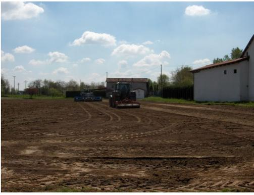
Foto n. 1 - Lavori preparatori - Fresatura e livellamento.
